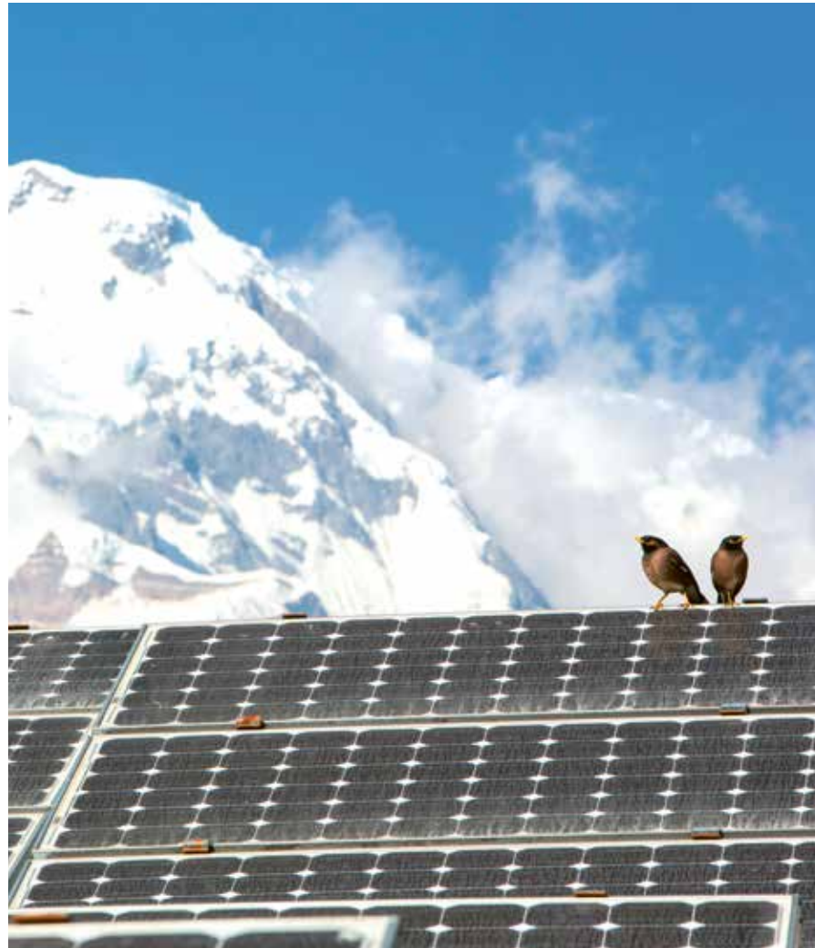
Mehr solarer Winterstrom im Gebirge: Es hat weniger Nebel, und die Reflexion des Sonnenlichts auf dem Schnee erhöht den Ertrag. Zudem steigert die Kälte den Wirkungsgrad.
