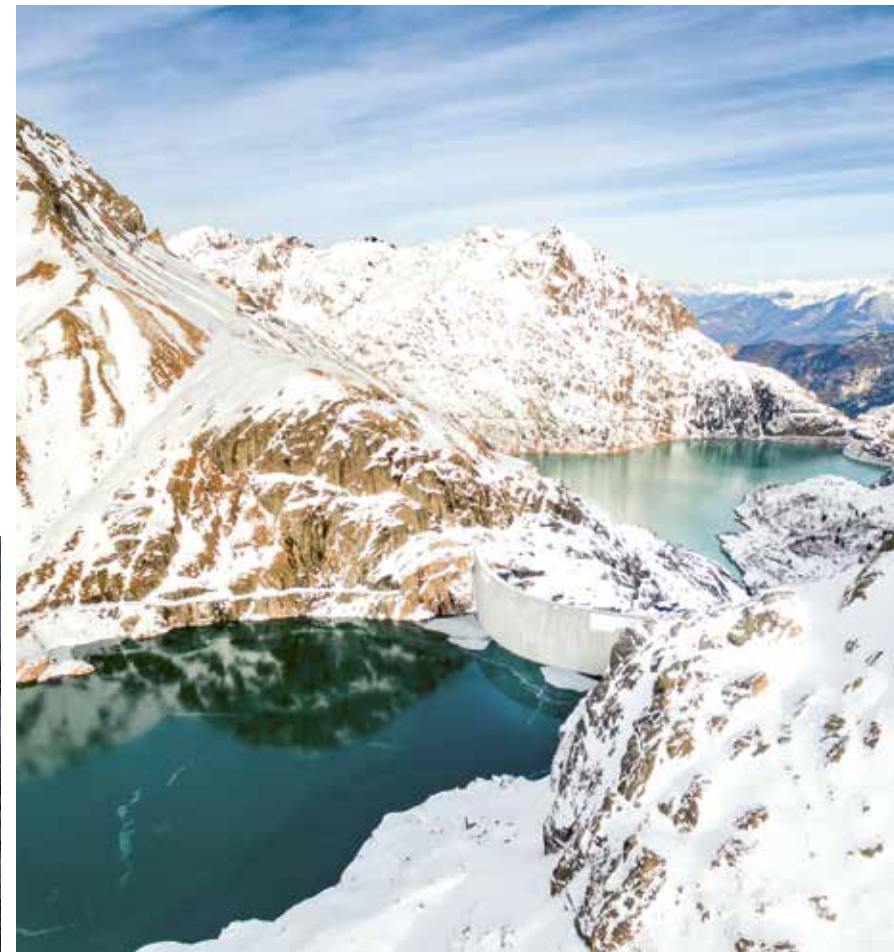
Der Staudamm Vieux-Émosson (links) ist Teil des neuen Pumpspeicherkraftwerks Nant de Drance.
