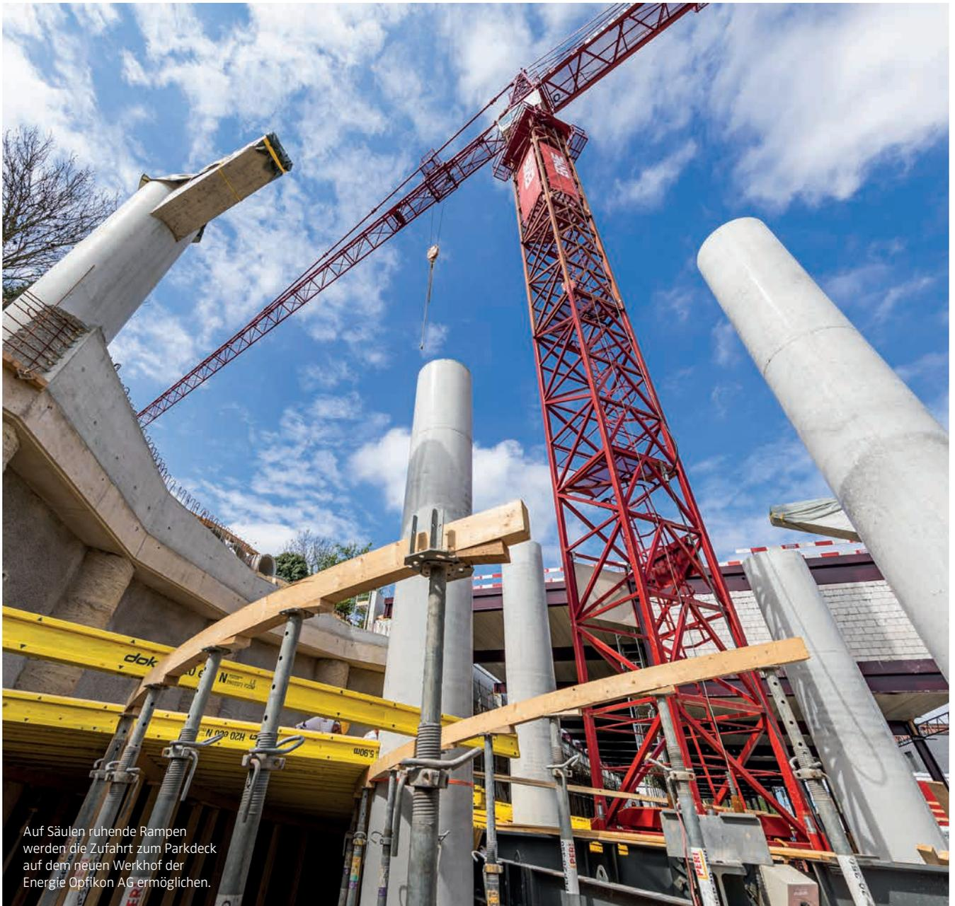
Auf Säulen ruhende Rampen werden die Zufahrt zum Parkdeck auf dem neuen Werkhof der Energie Opfikon AG ermöglichen.
