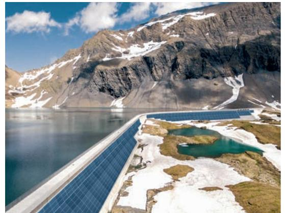
Seit 2017 ist das Pumpspeicherkraftwerk Limmern in den Glarner Alpen in Betrieb. Für das oben liegende Speicherbecken wurde der Mutsee durch eine 1054 Meter lange Staumauer vergrössert. Nun plant Axpo dort – auf 2500 Metern über Meer – die erste alpine Solar-Grossanlage: Auf der Staumauer sollen rund 6000 Photovoltaikmodule mit insgesamt 2 Megawatt Leistung installiert werden (vgl. Visualisierung).
