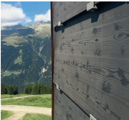
Nein, das ist kein Holz. Vielmehr handelt es sich um Photovoltaikmodule. Das Bergrestaurant Chäserstatt oberhalb von Ernen VS auf 1777 Metern über Meer hat Solarstrommodule in Holzoptik erhalten. Der Ertrag ist um 10 bis 20 Prozent tiefer als bei unbehandelten Modulen. Dafür werden diese Fassadenmodule nicht von Schnee bedeckt. Zudem erhöht die senkrechte Montage den Stromertrag im Winter, weil dann die Sonne sehr flach steht.
