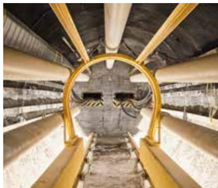
Der *Leioceras opalinum* (oben) kommt im Opalinuston sehr häufig vor. Die gelben Rohre der Verfüllmaschinen bringen Bentonitgranulat auch in die kleinsten Ritzen hinter dem Behälter (unten).
